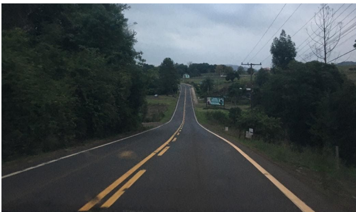
Figura 26 - Ausência de acostamento
