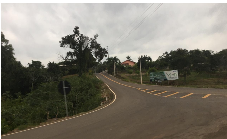
Figura 16 - Ausência de iluminação na interseção
