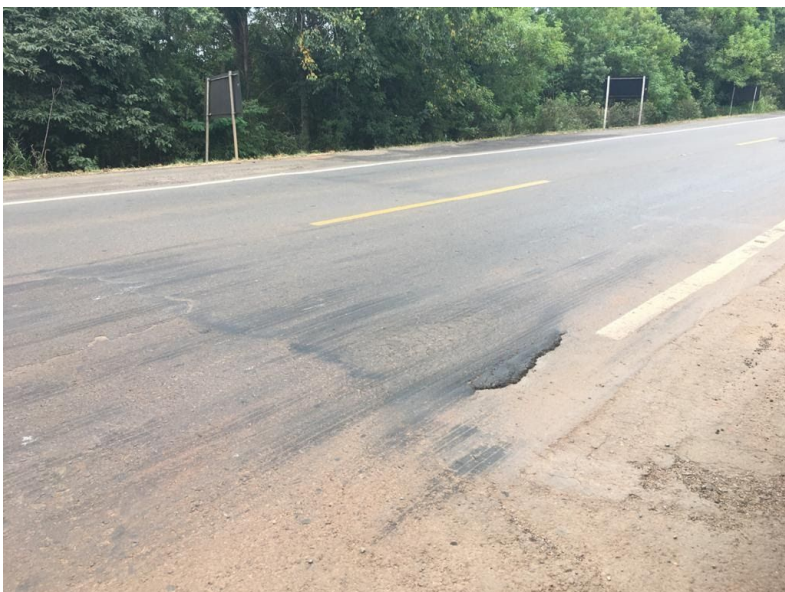
Figura 20 - Ondulação RSC-453
