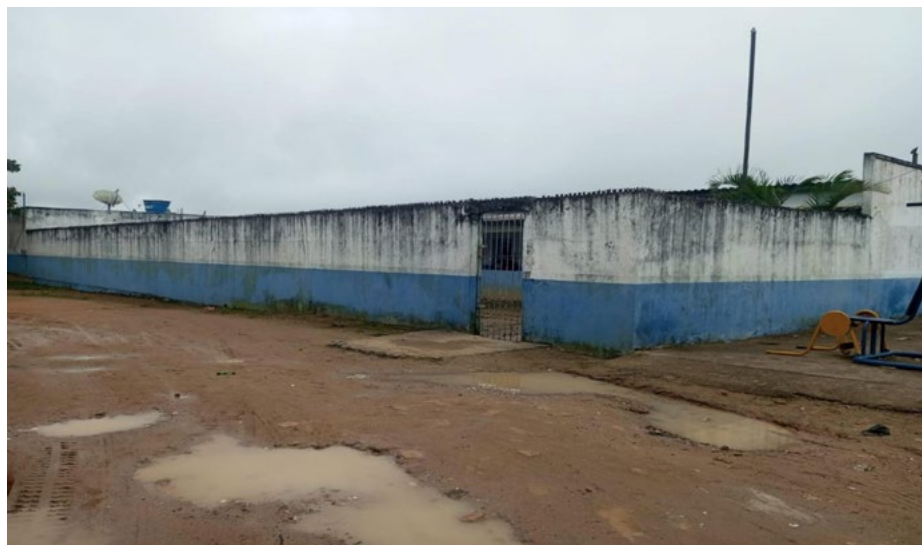
Fotografia 1 – Fachada da Escola Municipal Severino Ferrer de Moraes
