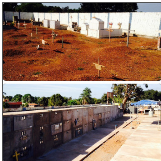
Figura 6 - Drenagem do B
