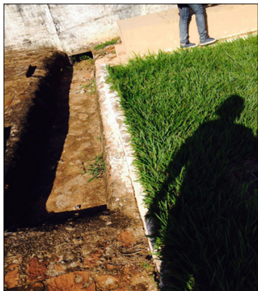
Figura 5 - Drenagem do A
