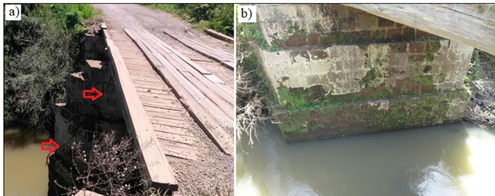
Figura 3 – a) fixação do tabuleiro na mesoestrutura; b) vegetação nos encontros
