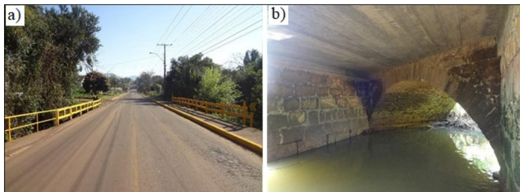
Figura 8 – Ponte 3 a) vista superior; b) vista inferior
