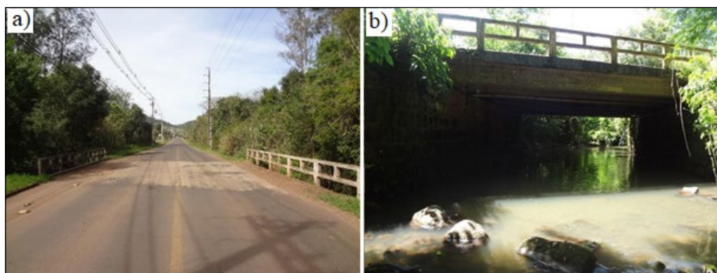
Figura 11 – Ponte 4 a) vista superior; b) vista inferior
