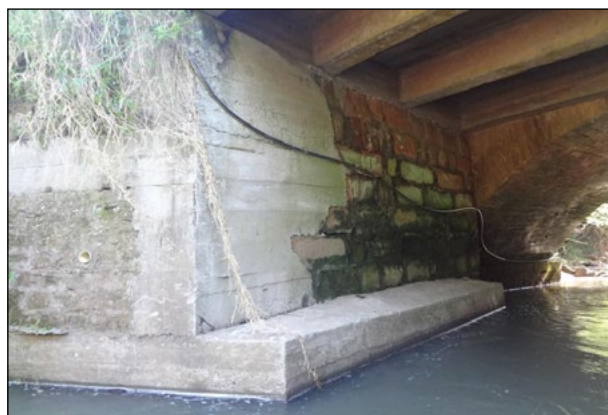
Figura 18 – Encontro reforçado no trecho de ampliação
