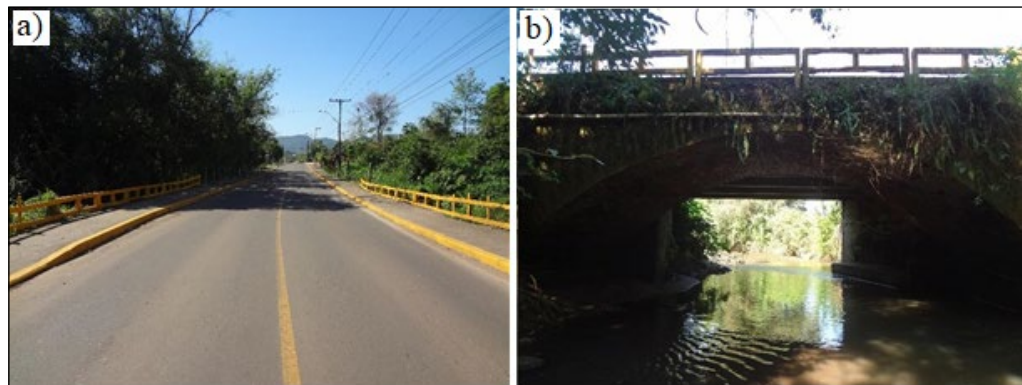
Figura 15 – Ponte 5 a) vista superior; b) vista inferior
