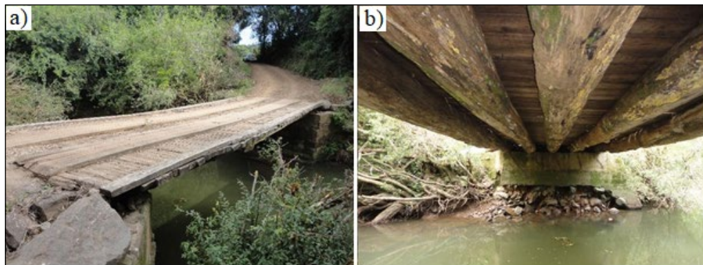
Figura 4 – Ponte 2 a) vista superior; b) vista inferior
