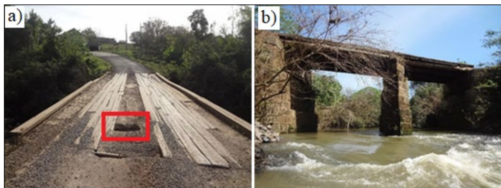
Figura 1 – Ponte 1 a) vista superior; b) vista inferior
