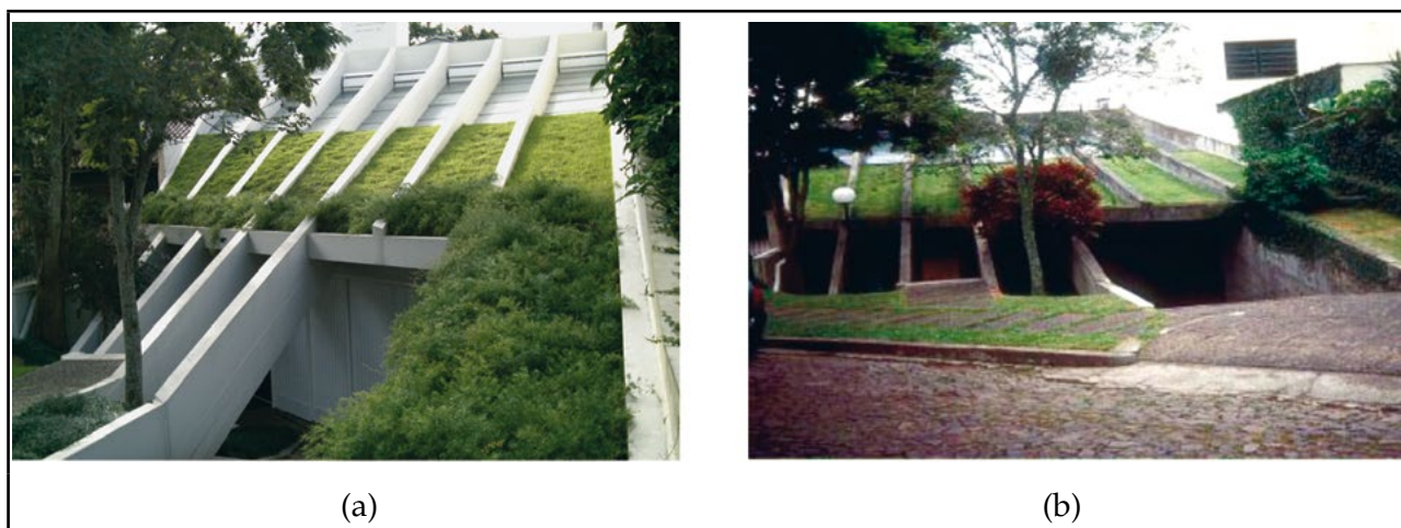
Figura 2 - Residência 1 no bairro Assunção: após a reforma (a) e, em 2003, com a cobertura original (b)
