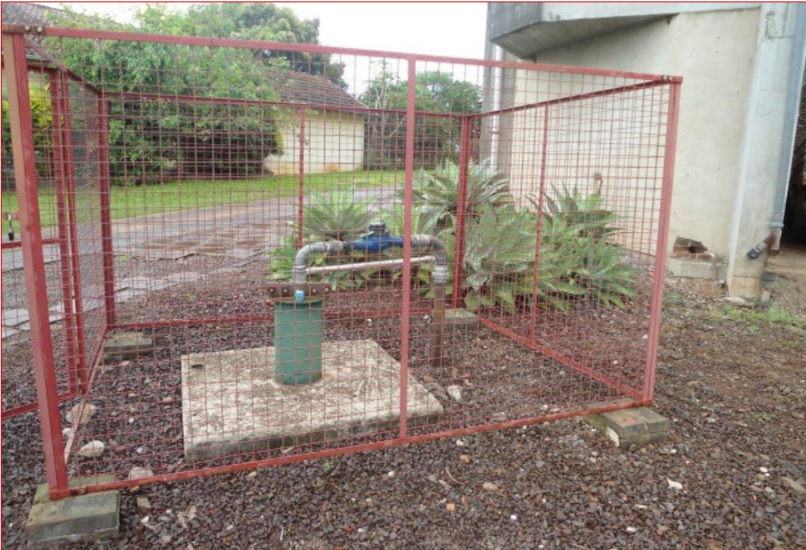
Figura 2 - Poço tubular utilizado para a coleta de 1L de água para análise em laboratório
