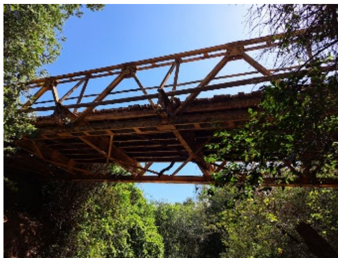
Figura 7. Ponte 02 - estrutura de ponte Bailey
