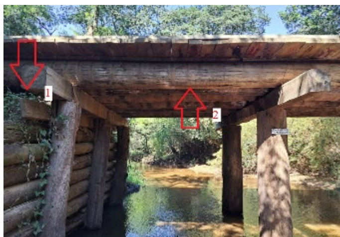
Figura 4. Vista da estrutura da ponte 01
