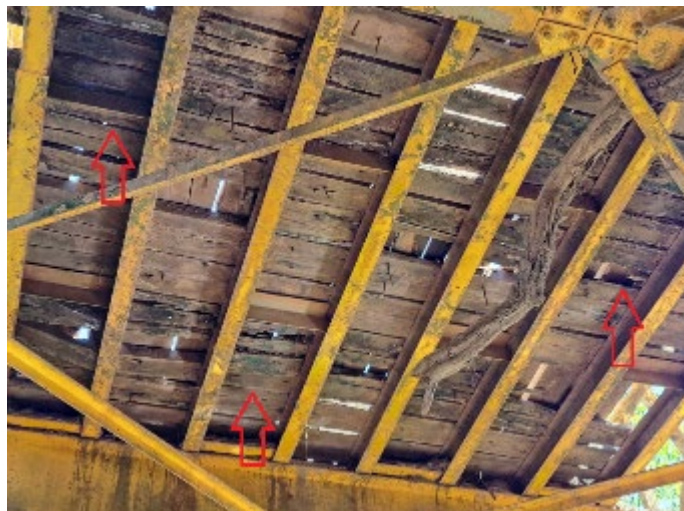
Figura 9. Vista da parte inferior do tabuleiro da ponte 02
