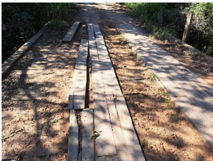
Figura 6. Vista do tabuleiro da ponte 01
