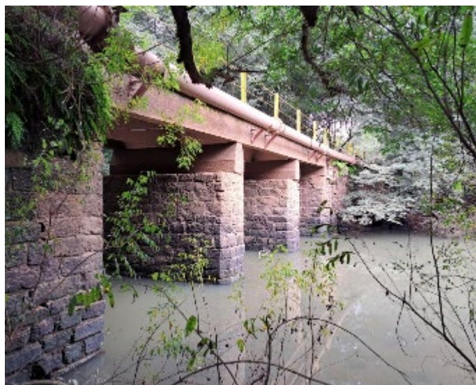
Figura 11. Vista lateral da ponte 03
