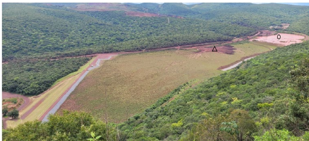
Figura 3 - Barragem do Gregório (Mina Santa Cruz)
