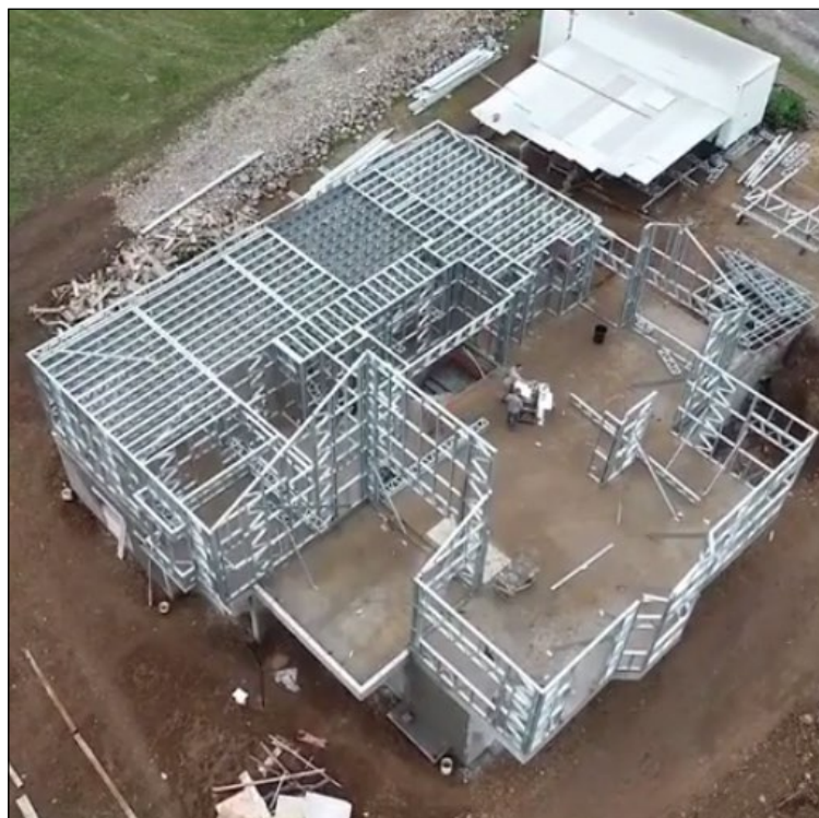
Figura 3 – Vista superior execução do pavimento térreo
