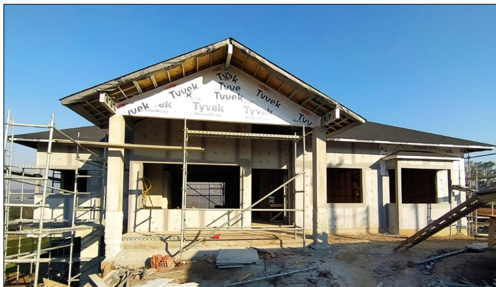
Figura 2 – Execução do pavimento térreo em LSF
