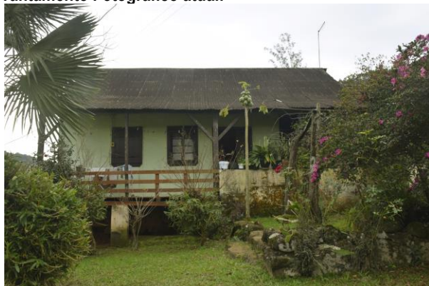
Fachada Lateral Residência VK
