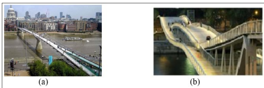
Figura 1 – Passarelas que indicaram problemas devido à vibração a) Millenium Bridge, Londres; b) Simone de Beauvoir, Paris.
