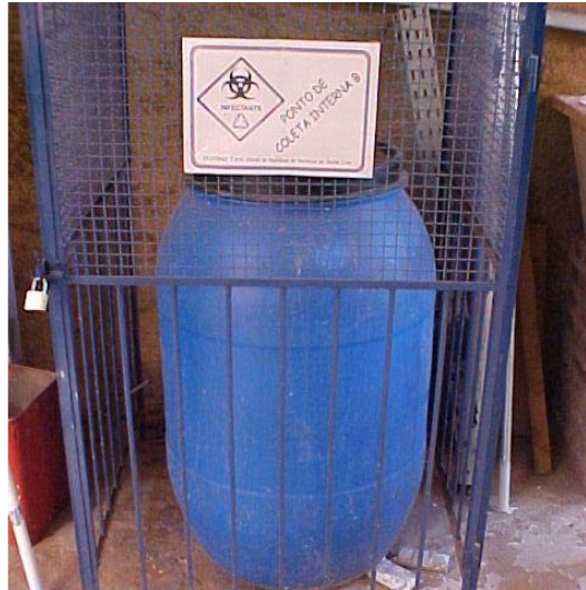
Figura 6 - Vista externa do Ponto de Coleta B dos resíduos infectantes. O recolhimento desses resíduos é realizado por empresa especializada devidamente licenciada pelo órgão estadual licenciador competente.
