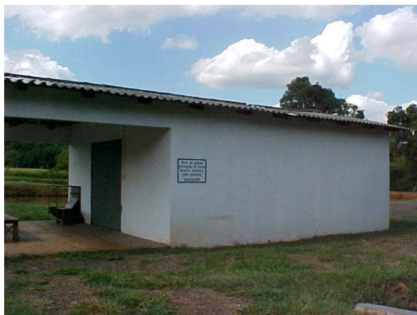
Figura 8 - Abrigo de Resíduos. Os resíduos perigosos produzidos pelas atividades desenvolvidas pela Instituição são estocados em área própria para posterior encaminhamento para tratamento externo. Exemplo de resíduos estocados: latas de tintas e solventes, lâmpadas e pilhas.
