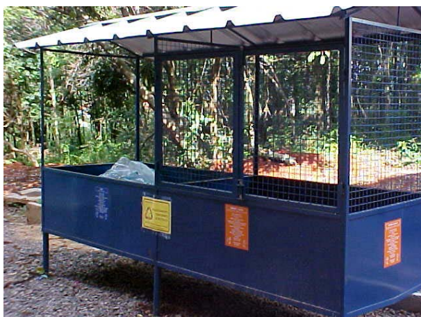
Figura 3 - Sub-estação de transbordo. O material recolhido das lixeiras fica temporariamente depositado nesses locais até seu recolhimento e destino final.
