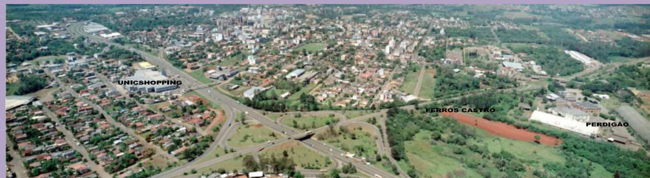
Vista Aérea do Terreno e do Cruzamento das vias
