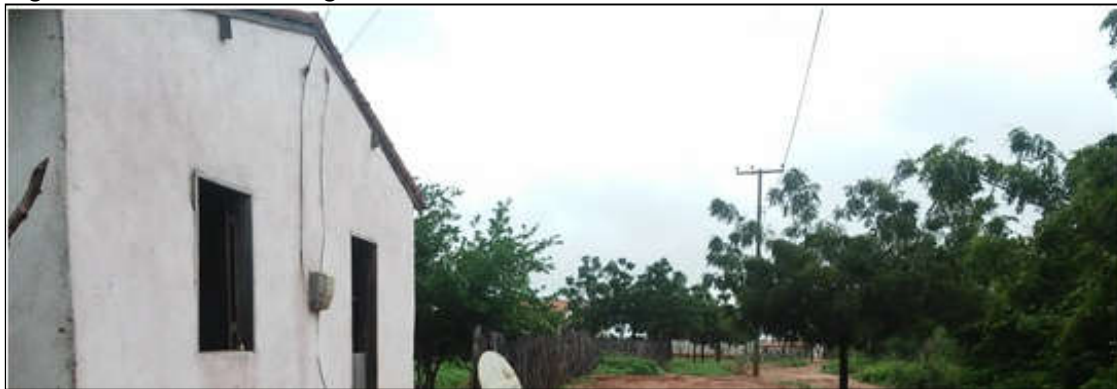
Figura 9 - Rede de energia elétrica no assentamento
