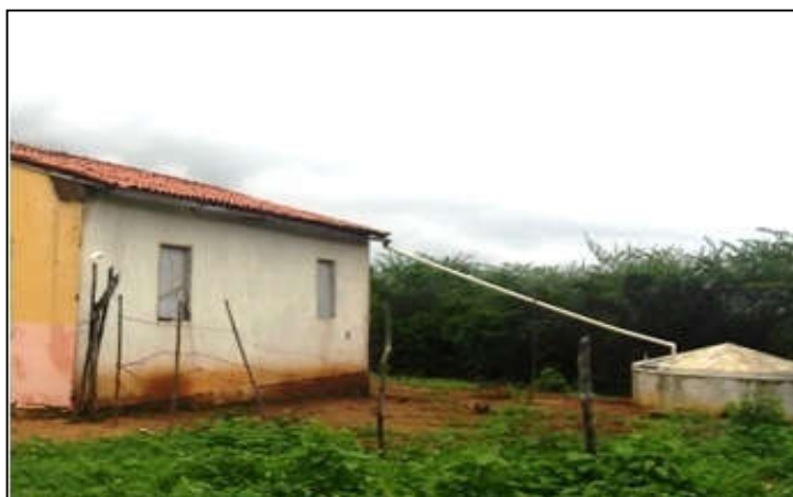
Figura 7 - Cisterna de placa instalada em 2014
