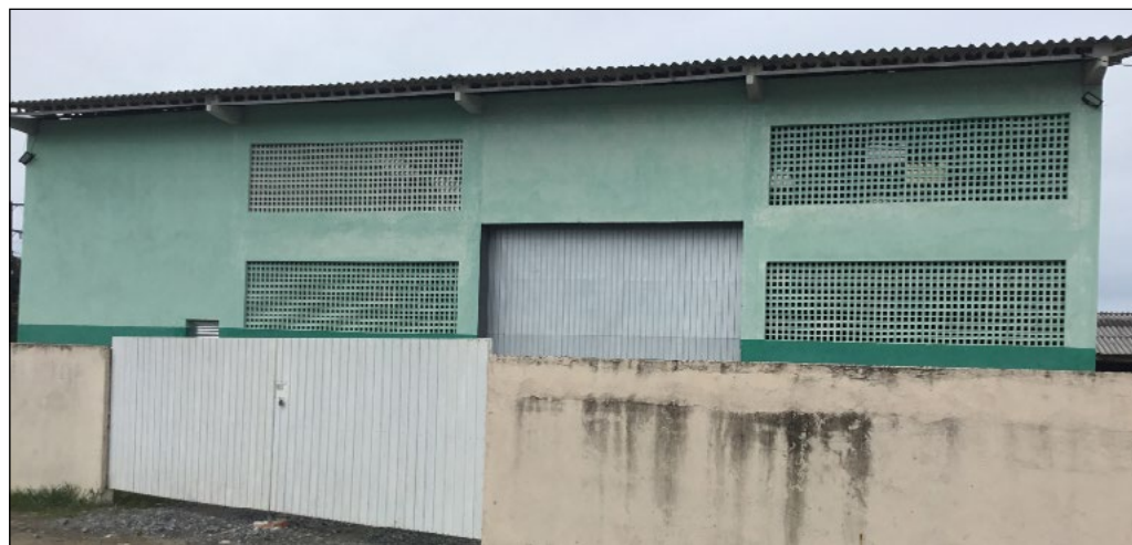
Figura 2 - Estação de Transbordo de Resíduos eletroeletrônicos domiciliares de Matinhos-PR
