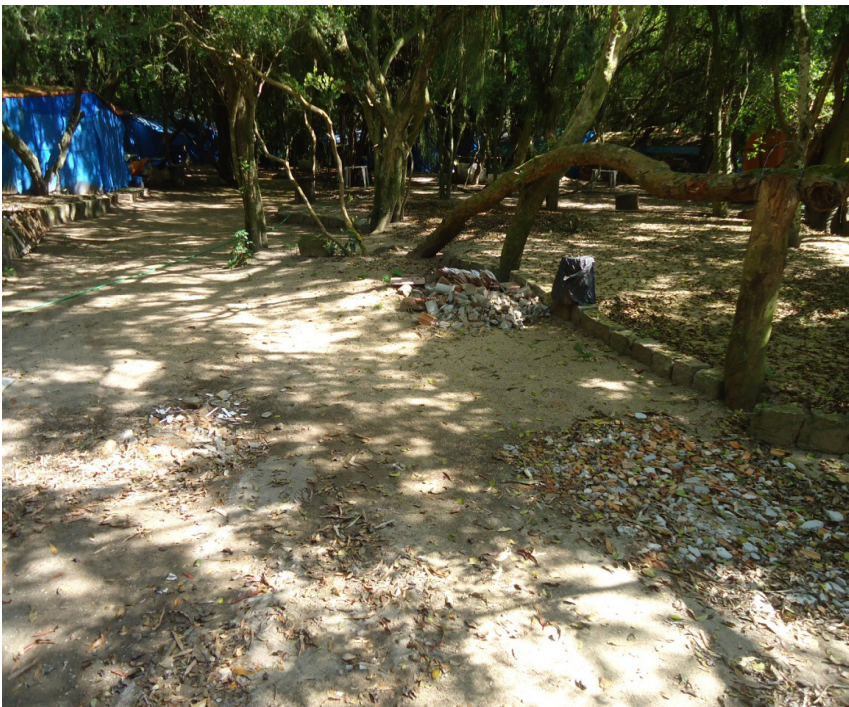
Figura 6 – Resíduos de construção da Pousada Vô Arthur - outubro de 2013
